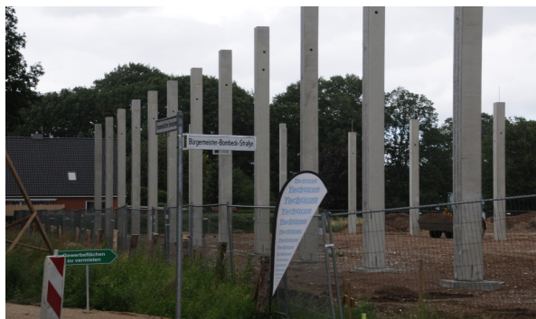
Bild 3: Kurz nach Baubeginn
